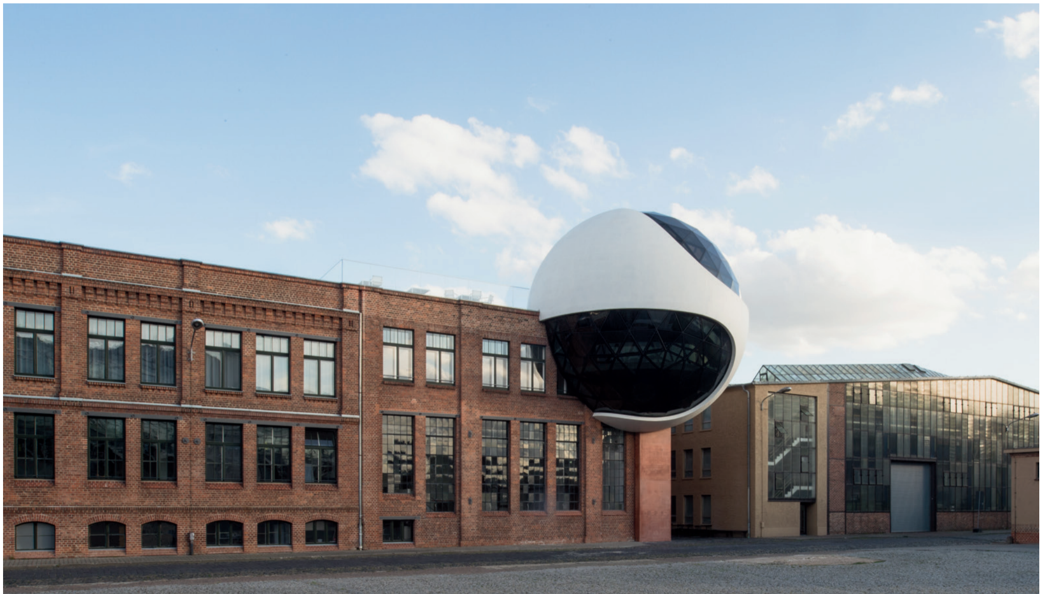
Der Kugelbau mit einem Durchmesser von 12 Metern erweitert das denkmalgeschützte ehemalige Dampfkesselhaus, in dem sich heute die für alle offene Kantine und darüber ein Speisesaal befinden.
