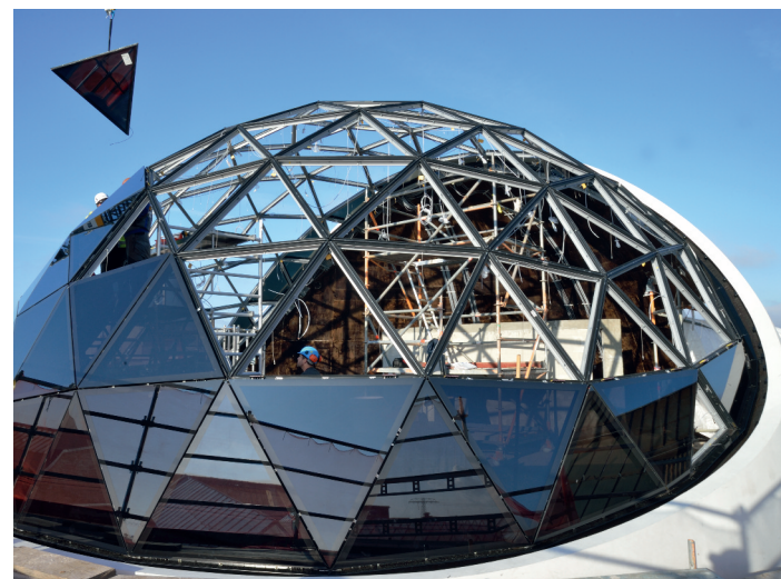
Geodätische Kuppeln, seit den 1940er Jahren von Richard Buckminster Fuller entwickelt, sind Gitterstrukturen, die Leichtigkeit mit stabiler Konstruktion verbinden.
